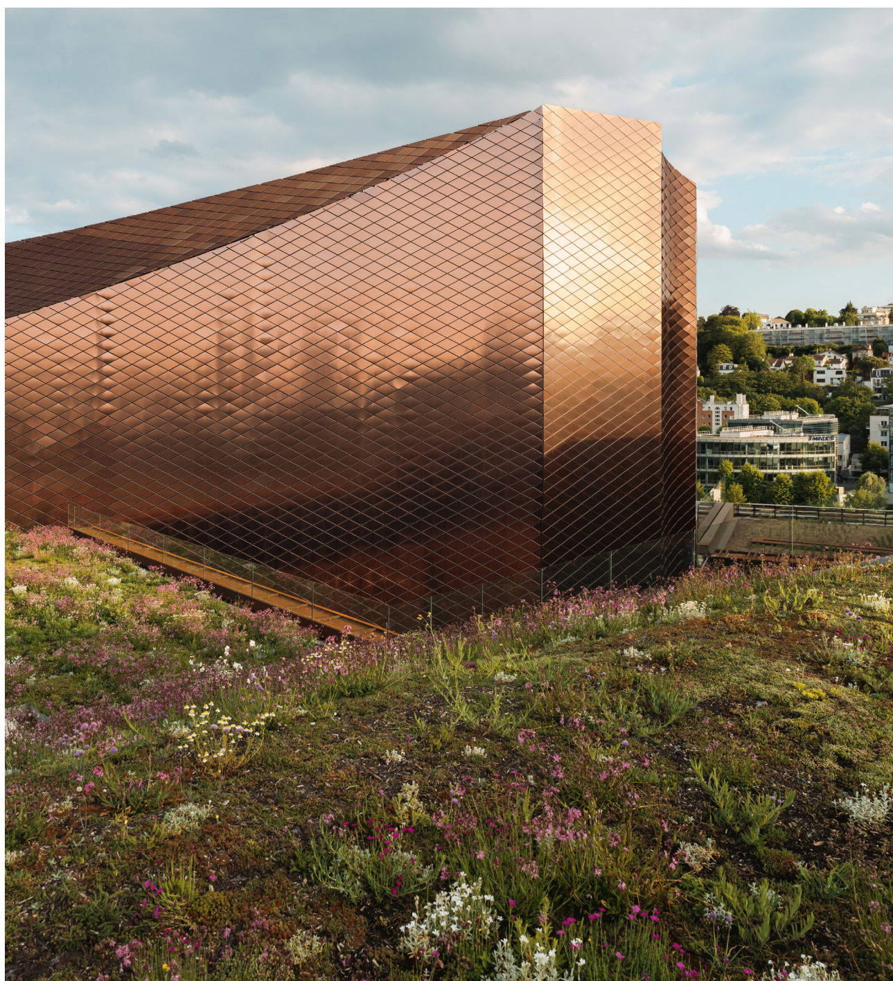
Large, toitures plantées, Photographie ©Nicolas Trouillard, Île Seguin, Boulogne-Billancourt, France. ©RCR Architectes et CALQ
